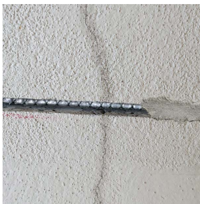
Einbau in oberflächennahe Nuten bei bestehenden Strukturen
