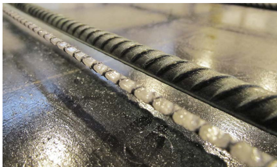
EpsilonSensor neben der Bewehrung kurz vor der Betonage der Platte
