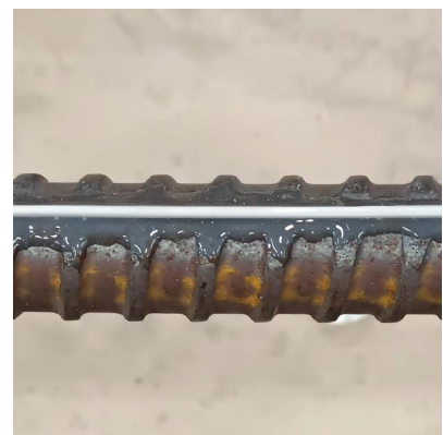
Verklebung direkt auf der geschliffenen, gereinigten und entfetteten Bauteiloberfläche
