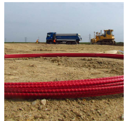
Einbettung in die Bodenstruktur
