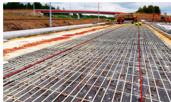
Anwendung von EpsilonRebar in einer intelligenten Betonautobahn
