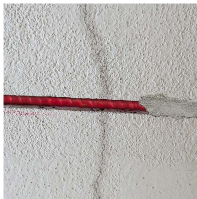
Einbau in oberflächennahe Nuten bestehender Bauwerken
