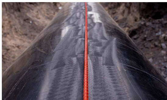
Anwendung von EpsilonRebar auf einer Stahlgasleitung
