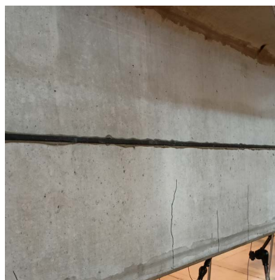
Installation auf Betonoberfläche
