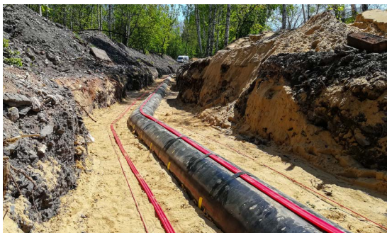
Anwendung des 3DSensors entlang einer Gasrohrleitung
